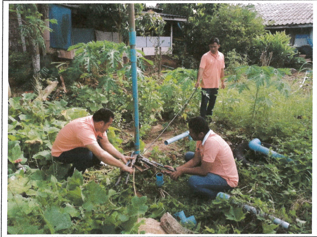
โครงการเป่าล้างบ่อบาดาล
